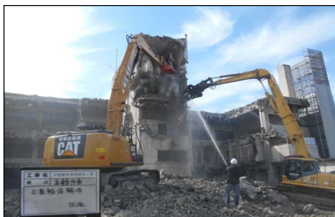
【滋賀県】 甲賀警察署他解体工事 平成29年11月～平成30年3月
